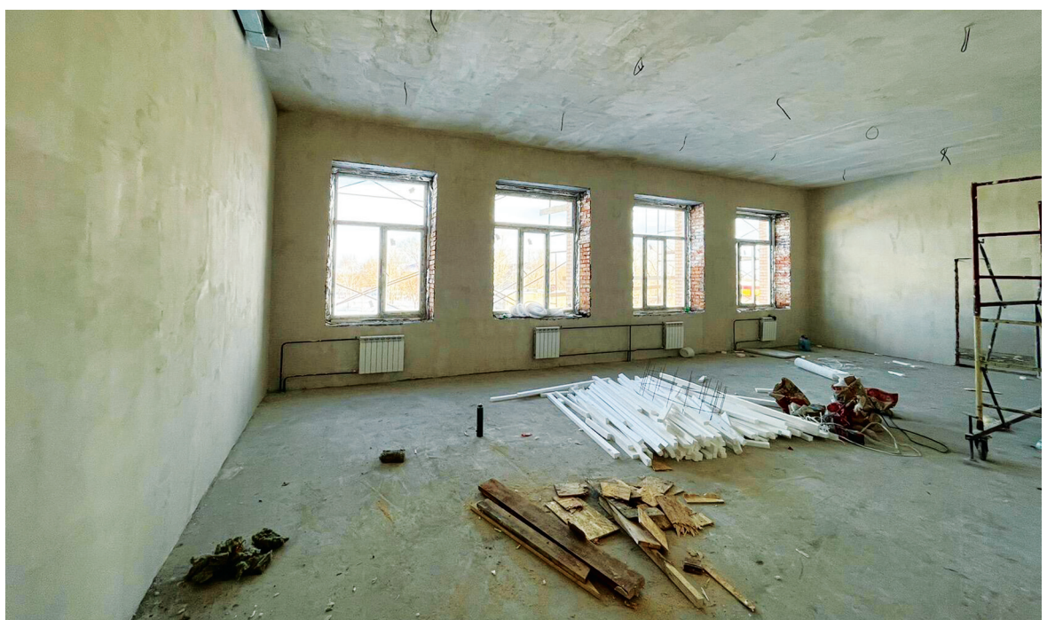
Строители приступили к отделке помещений
