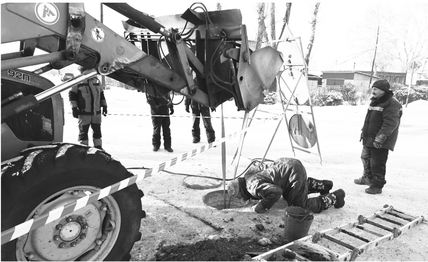
Ремонт водопровода в Бее. Начальные работы
