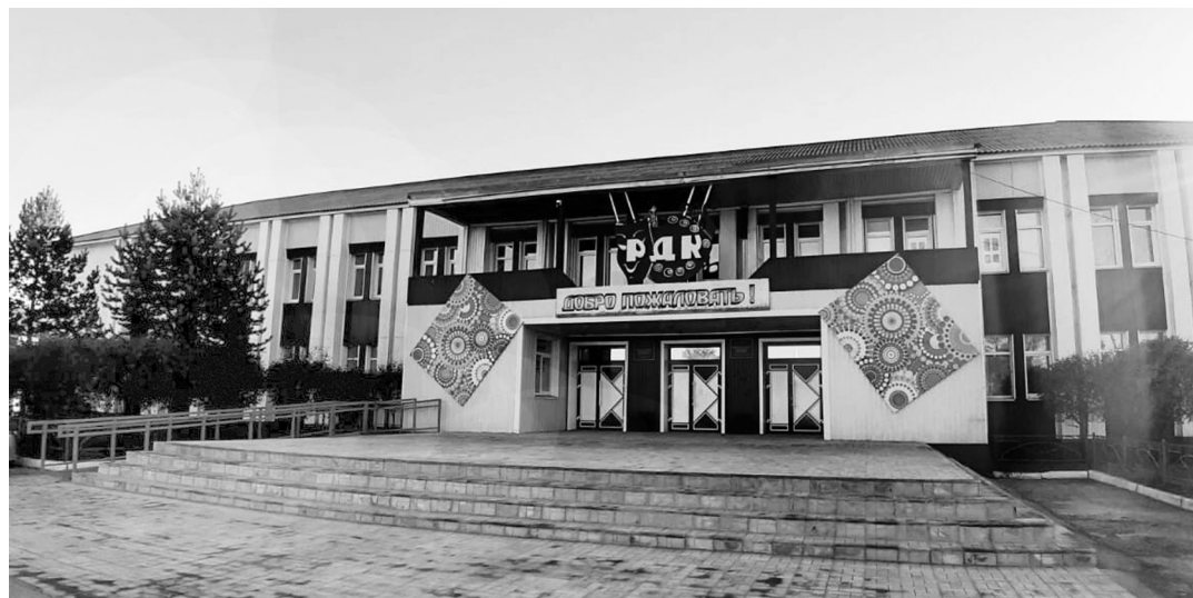
Районный дом культуры после ремонта крыльца
